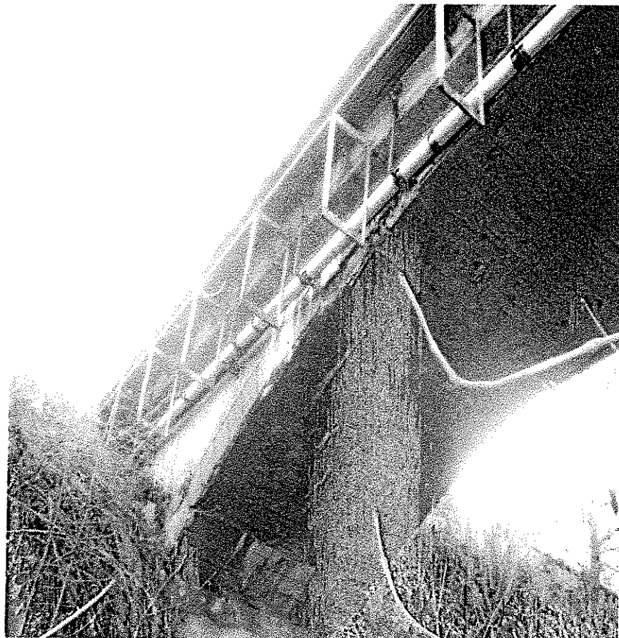
Zdjęcie nr 1 – widok mostu od spodu
